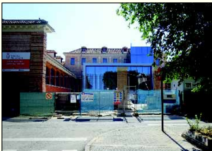
En las obras de la fachada de la calle Capitán parece que está el problema.
