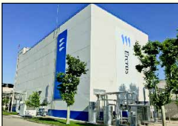
El proyecto estrella ya está en marcha: la construcción de una nueva planta en la que se fabricarán nuevos productos que demanda el mercado farmacéutico mundial. En la imagen, una de las plantas que conforman la fábrica de Ercros en Aranjuez.
